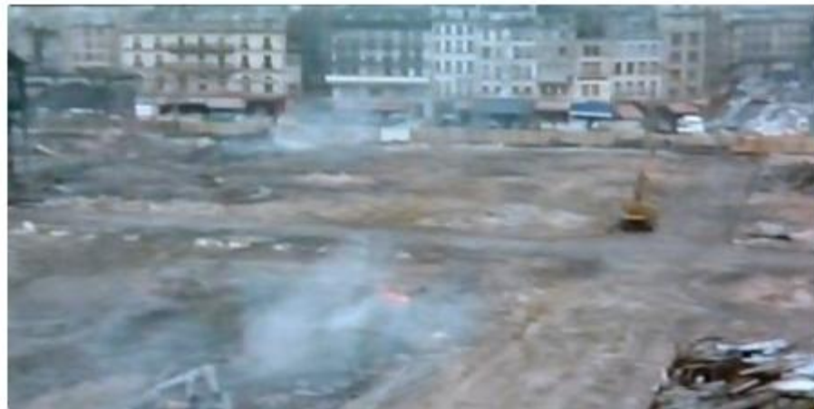
Destruction des pavillons en 1971. Rue Rambuteau au second plan
