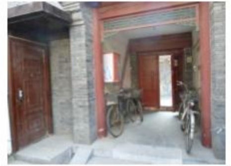
Portique de l'entrée
