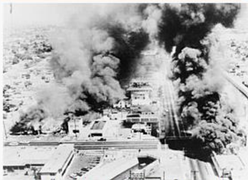
Les bâtiments du quartier de Watts en feu pendant les émeutes.
